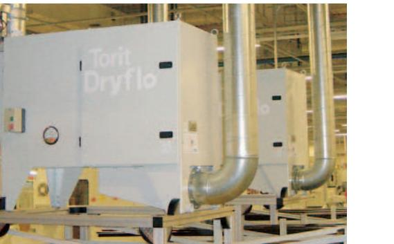
► Ambos equipos son extremadamente eficientes y utilizan el contrastado sistema Donaldson de tres etapas de filtración, especialmente diseñado para la captación de las neblinas. Cuando más funciona la unidad, más aumenta la eficacia del cartucho filtrante.
