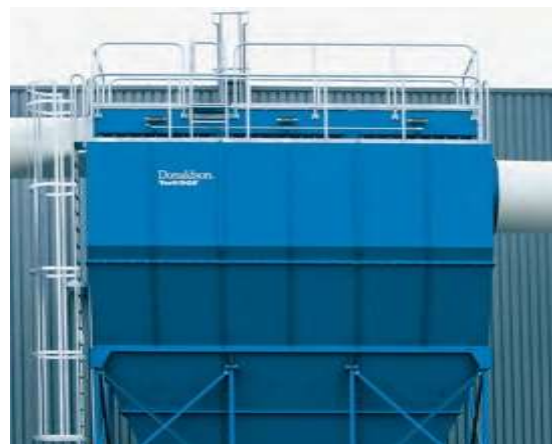
Filtro modular de mangas tubulares
