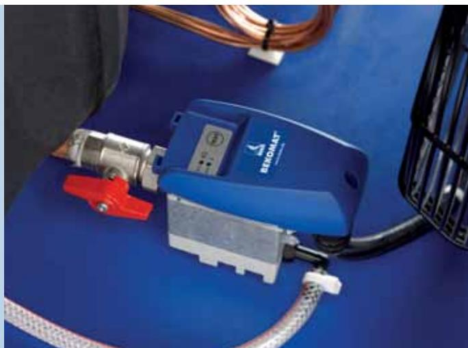
**Evacuación de condensados sin pérdidas de aire comprimido:**
